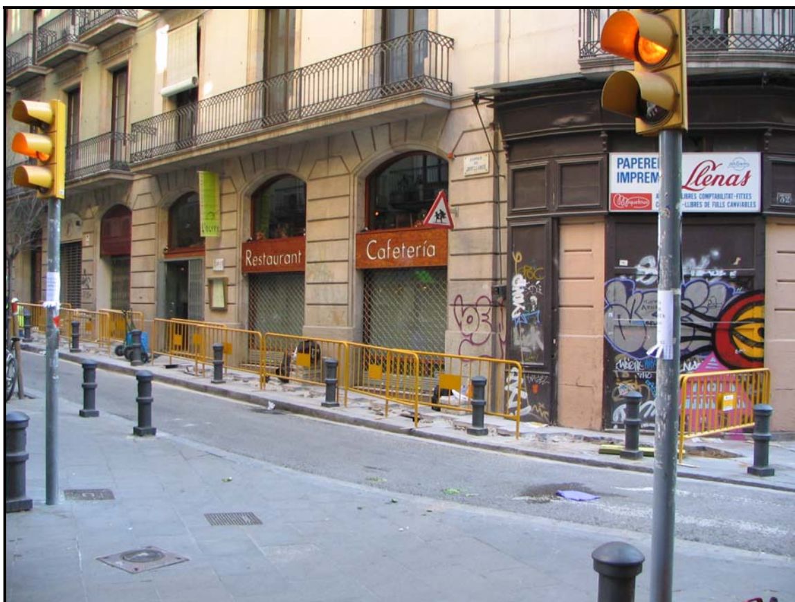
Fotografia 1: Vista general de la situació de la rasa del carrer Jovellanos.
