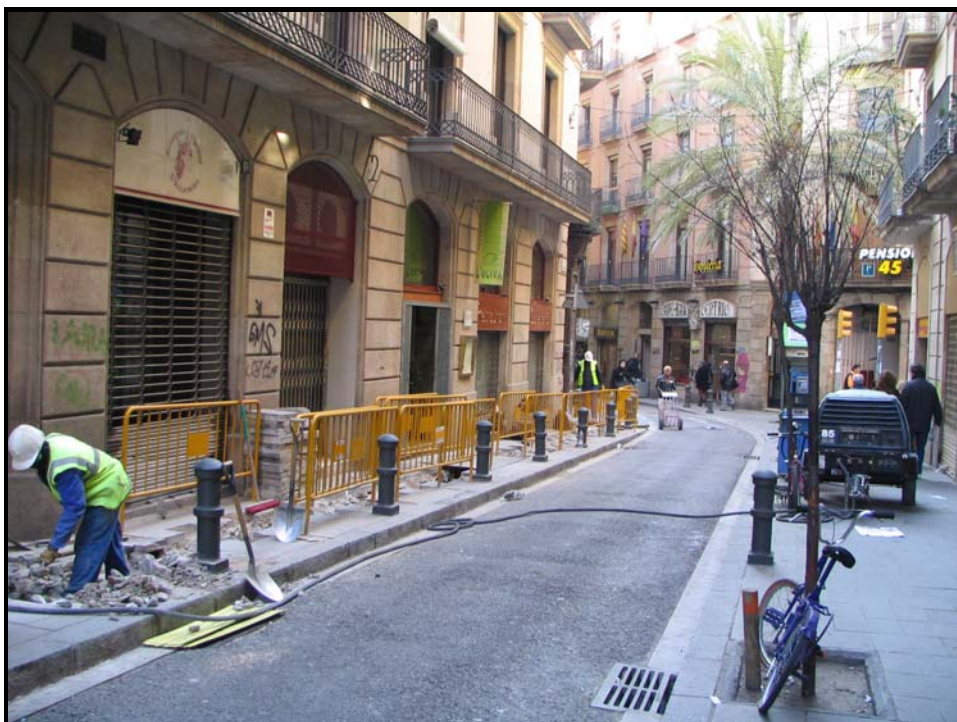
Fotografia 3: Vista general de la rasa en direcció a la cantonada amb el c/ Tallers, on s'observen els treballs manuals de l'operari alhora de realitzar la rasa.
