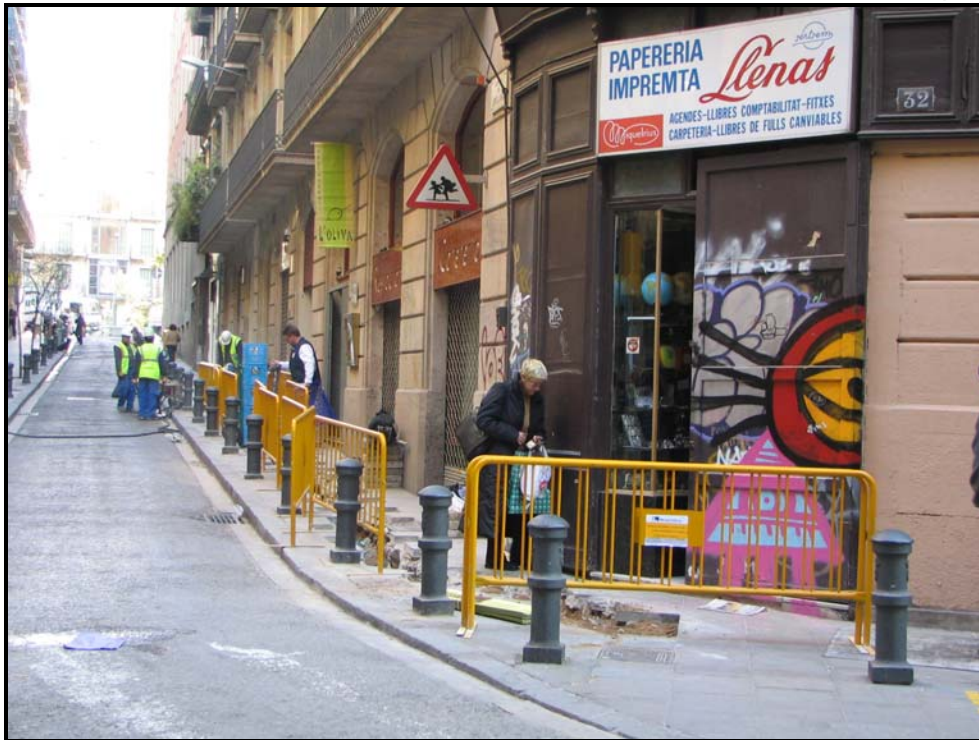
Fotografia 2: Vista general de la rasa del c/ Jovellanos des de la cantonada amb el c/ Tallers.
