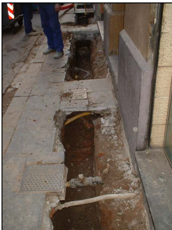
Fotografia 5: Vista de la rasa, on s'observen la quantitat de serveis existents.
